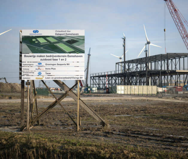
Datacentrum Google in aanbouw. De zoekgigant kiest voor het gebied omdat het door de beschikbaarheid van energie en de goede infrastructuur aantrekkelijk is. Ook het Nederlandse klimaat speelt mee. Foto: Hollandse Hoogte/Kick Smeets Fotografie
