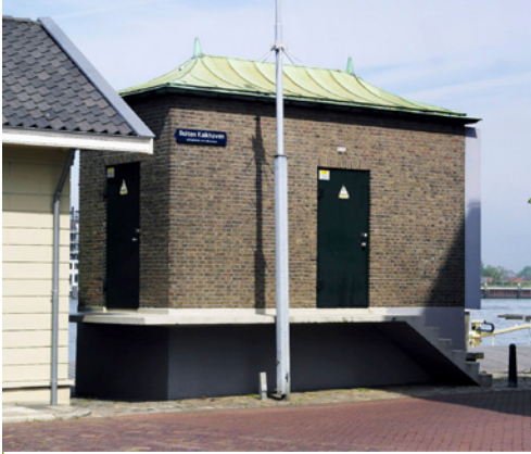
Een verhoogd 50 kV-schakelstation (Stedin) aan de Buiten Kalkhaven in Dordrecht, zodat het minder snel onder water loopt. Foto: Melle van Overbeek.
