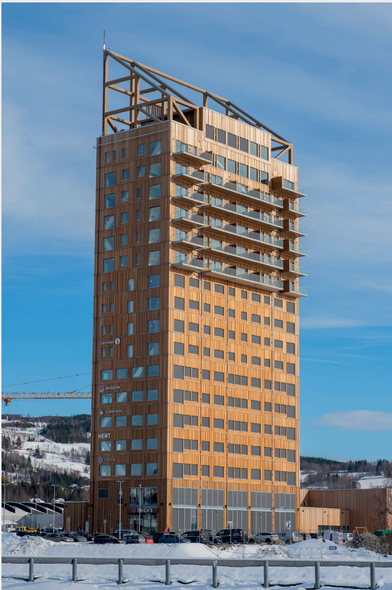
Afb. 5 Mjøstårnet, 's werelds hoogste houten gebouw, gemaakt met CLT
