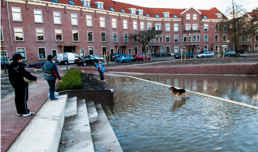
Door een slimme inrichting met bijvoorbeeld de aanleg van waterpleinen kan wateroverlast in de stad door hevige regenbuien worden voorkomen (Water Plaza, Bentheimplein Rotterdam).
